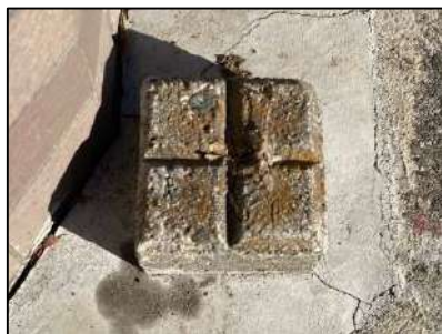
境界標（コンクリート杭）
