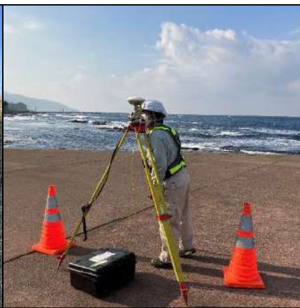
GNSS測量機 (スタティック法)
